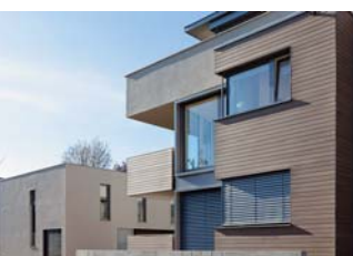
Neubauten Straßburger-/ Kirchbachstraße Planung und Bauleitung: as Planungsgesellschaft
