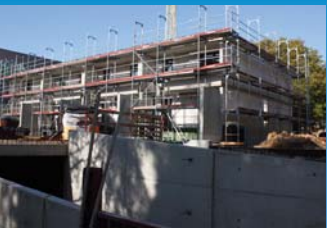
Hinter der Ladenzeile Planung und Bauleitung: Architekturbüro Geiser
