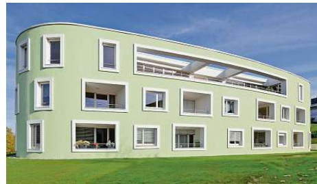
Auf dem vom Pflegeheim „August-Kayser-Stiftung“ erworbenen Grundstück an der Kantstraße 63-67 wurden zwischen Sommer bis Herbst vergangenen Jahres 30 Miet- und Eigentumswohnungen in drei Baukörpern bezogen. Neun Wohnungen werden verkauft, 21 Wohnungen verbleiben im Eigentum der Tochter der Baugenossenschaft, Arlinger ServiceWohnen, die als Bauherrin fungierte. FOTO: FRIESE
