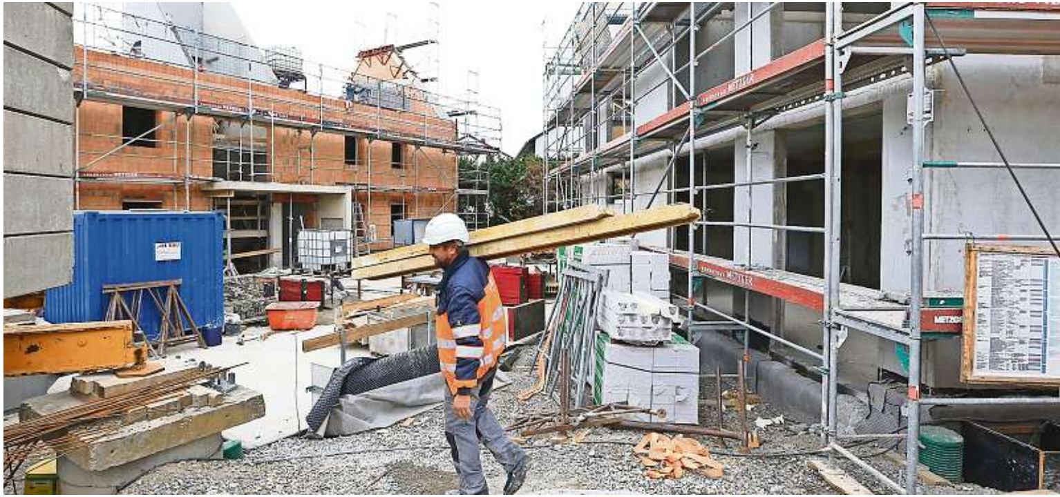
Es geht voran mit der Großbaustelle mitten in Kieselbronn: Ein Wohnhaus und ein Gebäude für ein Bäckerei-Café und Wohnungen sind auf dem früheren Bauhof-Areal im Rohbau schon gut zu erkennen. Für den 23. November ist das Richtfest geplant.
