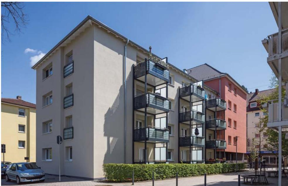
Das doppelte Mehrfamilienhaus mit den Nummern 96 und 98 erhielt eine neue Gebäudehülle: Fassade, Dach sowie unterste und oberste Geschossdecke wurden wirksam gedämmt. Die vorgesetzten Balkone steigern den Wohnkomfort, der Klinkersockel verleiht dem Gebäude einen klassischen, wertigen Look.
