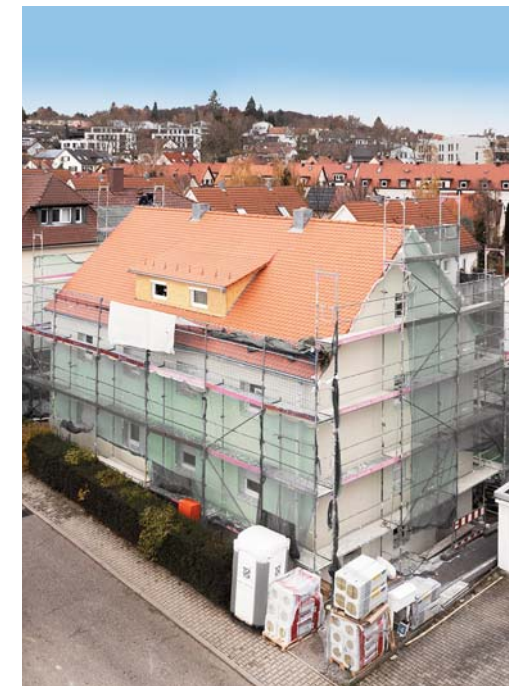
Technisch und energetisch aufgerüstet: Wohnhaus in der Mahlbergstraße
