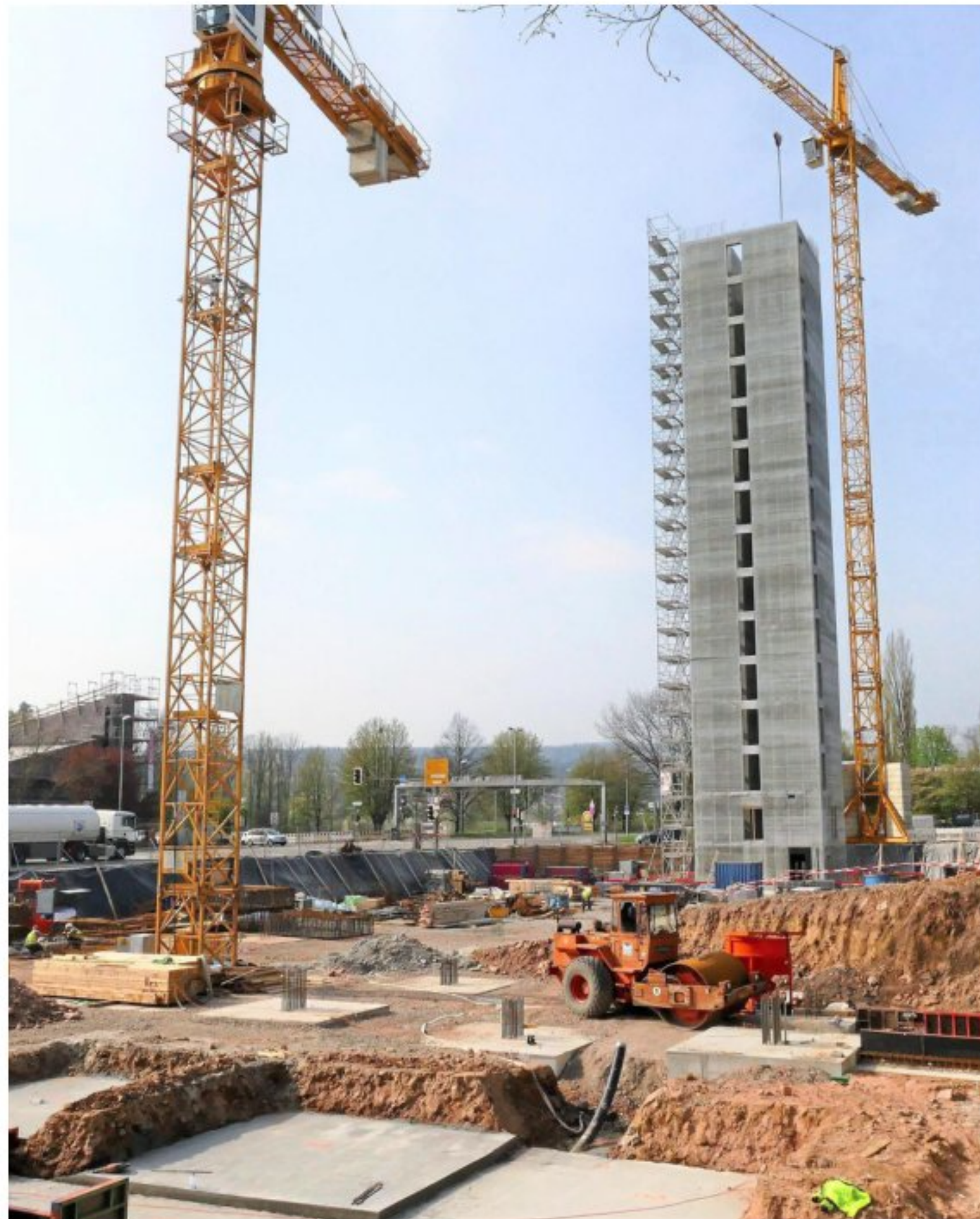
Treppenhaus steht: Vor Ostern wurde das Treppenhaus von „Carl“ in Stahlbeton fertiggestellt. Es bildet den Kern des Holzhochhauses. Foto: Jürgen Peche
