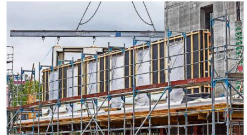
So sehen die vorgefertigten Wände aus, die die Arbeiter auf der Baustelle am Eingang zum Arlinger montieren. Im Rhythmus von 14 Tagen geht es von einer zur nächsten Etage.
