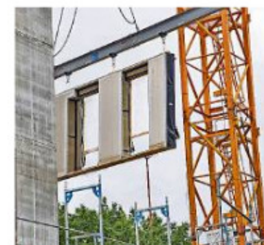
Die einzelnen Fassadenelemente werden mit einem Kran auf der Baustelle eingeschwenkt.
