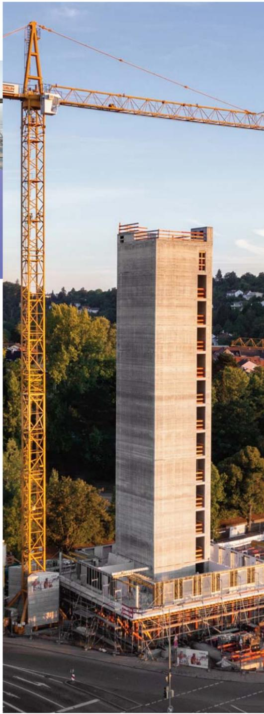
CARL ist derzeit das höchste Holz-Hybrid-Hochhaus Deutschlands. „Hybrid“ bedeutet: Nicht alles wird mit Holz gebaut. Aus statischen und brandschutztechnischen Erfordernissen wird für den Treppenhaus-Kern klassischer Stahl-Beton verwendet. Gleichwohl sparen wir durch den nachwachsenden Rohstoff Holz 2.000 Tonnen CO<sub>2</sub> ein, im Vergleich zur konventionellen Bauweise.
