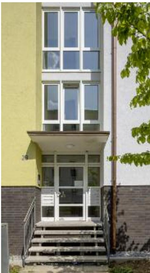
Priorität hatten jene Maßnahmen mit direkten Auswirkungen auf die Energie-Fitness der Mehrfamilienwohnhäuser: Die Gebäudehülle wurde erneuert. Fassade und Dach, aber auch die erste und letzte Geschossdecke erhielten eine effektive Dämmung.
