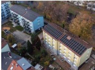
Dämmung, Fenster und Balkone in der Steubenstraße 61+62
