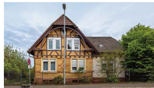
Arlingerstraße 33 Ein Gartenstadt-Klassiker, Baujahr 1901. Das Zweifamilienhaus steht derzeit leer und wartet auf seine Sanierung in 2024.
