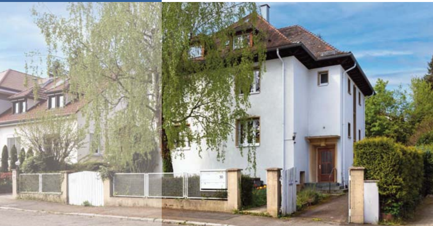
Friedenstraße 30 Dieses Dreifamilienhaus aus dem Jahr 1948 ist derzeit überwiegend unbewohnt. Eine umfassende Sanierung steht 2024 an.
