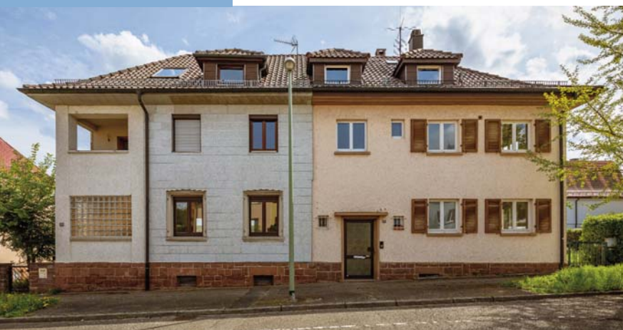
Brendstraße 23 Auch dieses Zweifamilienhaus, Baujahr 1924, ist sanierungsbedürftig. Es steht derzeit leer.
